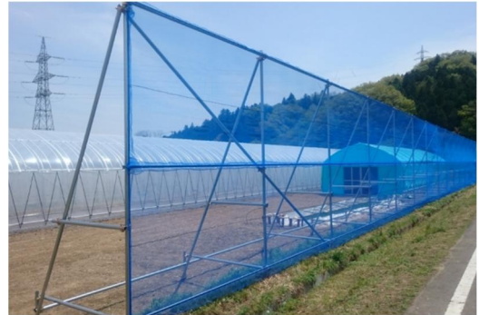
防風ネットの設置
