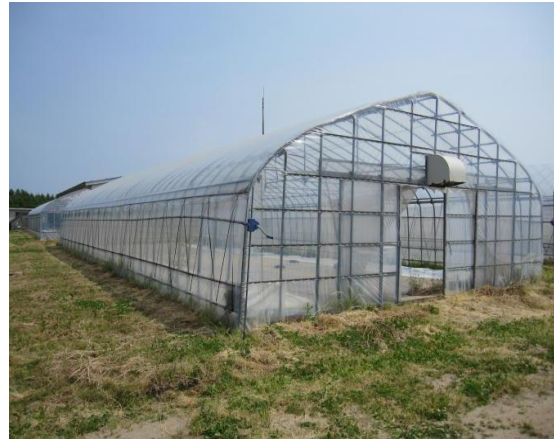
パイプハウス
