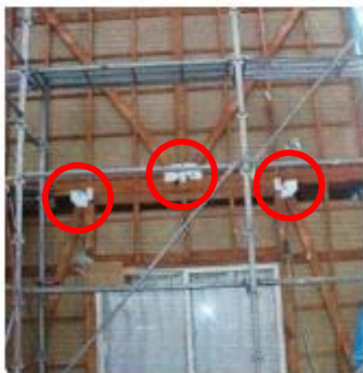
筋交い端部の金物補強
