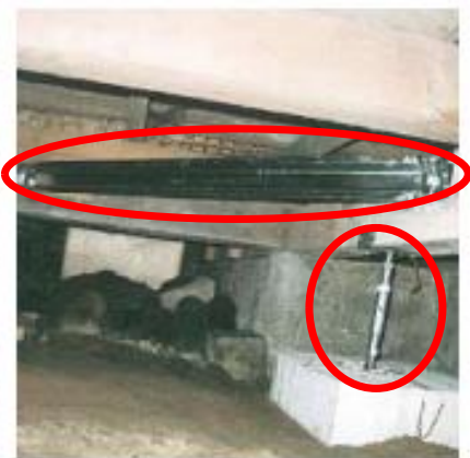
床下の金物補強
