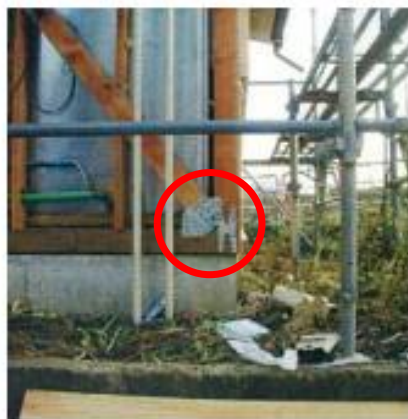
柱端部の金物補強
