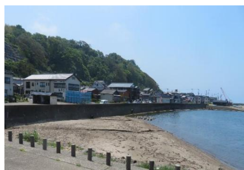
背後集落を守る海岸保全施設
