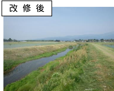
< 湛水被害防止のための排水路改修 >
