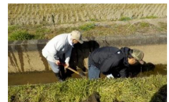
< 水路の泥上げ >
