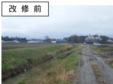
< 湛水被害防止のための排水路改修 >
