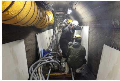
< コンクリート隧道のコンクリートパネル設置による補強 >
