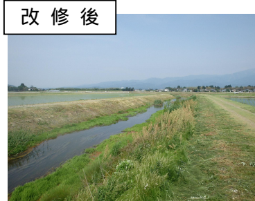
< 湛水被害防止のための排水路改修 >
