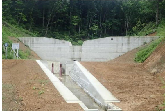
下小野中沢(砂防堰堤:R5完了)
