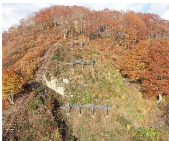
< なだれ予防工（スノーネット）設置完了 >
