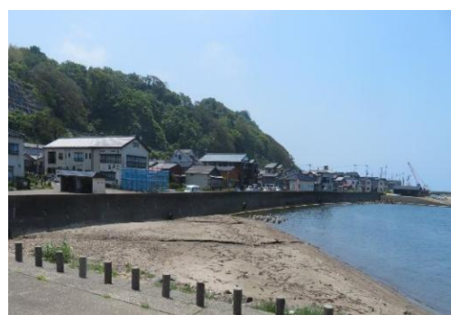
背後集落を守る海岸保全施設
