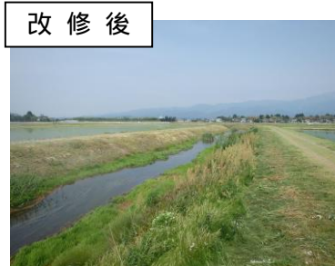
< 湛水被害防止のための排水路改修 >
