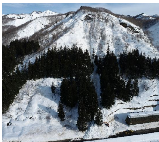
< 令和7年1月に発生したなだれにより、一般国道252号が閉塞 >
