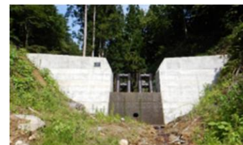
<流木捕捉式治山ダム工>
