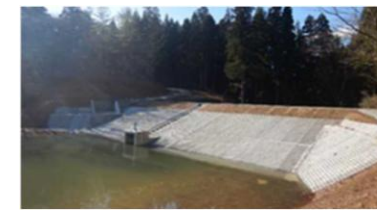
<防災重点農業用ため池の整備>
