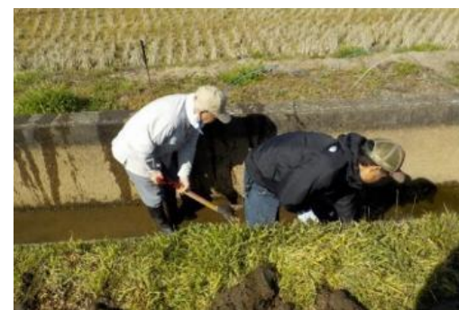
<水路の泥上げ>
