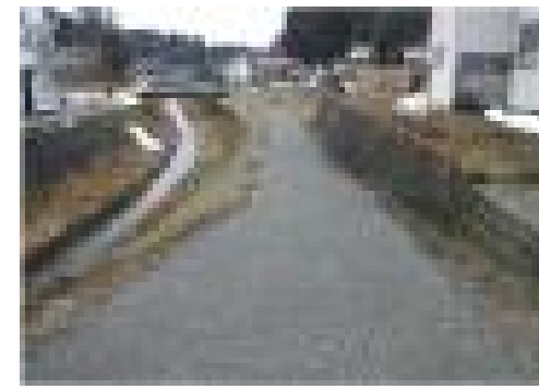
施工中(R7年12月)
