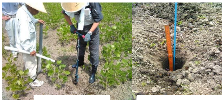
縦穴施工の様子
