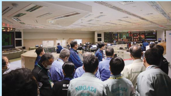
総合負荷性能検査の実施状況の確認（中央制御室）
