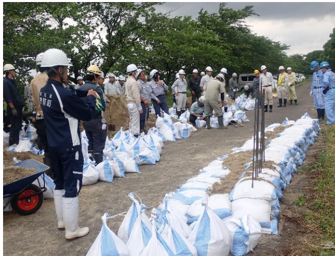
積み土のう工
