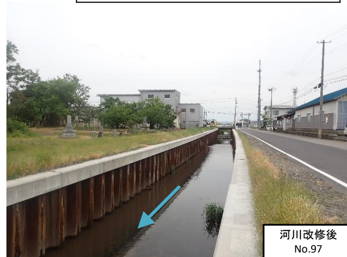
矢板護岸及び地盤改良
