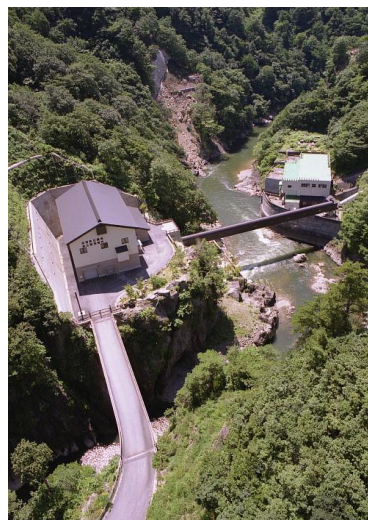
奥三面発電所(左) 猿田発電所(右)
