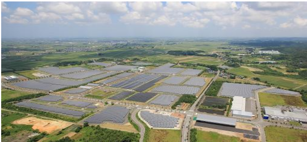
(上) 新潟東部太陽光発電所全景
