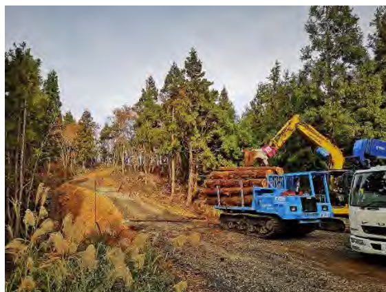
林道の支線となる林業専用道からの 集材・積み込み状況
