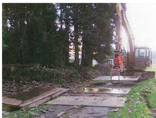
敷鉄板による既設道補強
