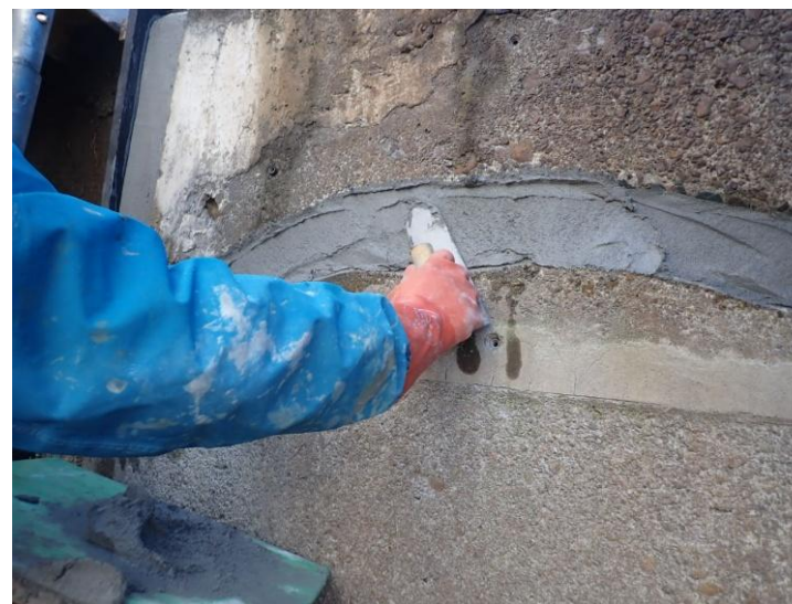
補修状況写真
