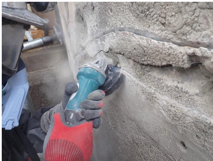
補修状況写真
