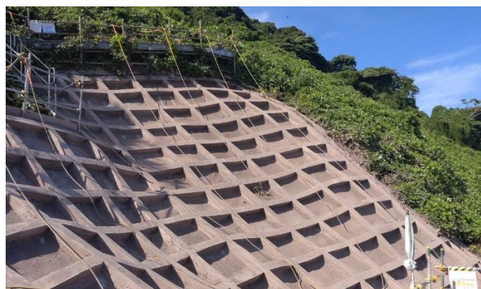
メンテナンス工事完了後の法枠工の状態 (B-2ブロック)
