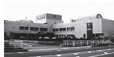
病院正面全容（国道7号線沿い）
