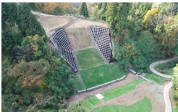
治山事業による山地災害からの復旧（小千谷市）
