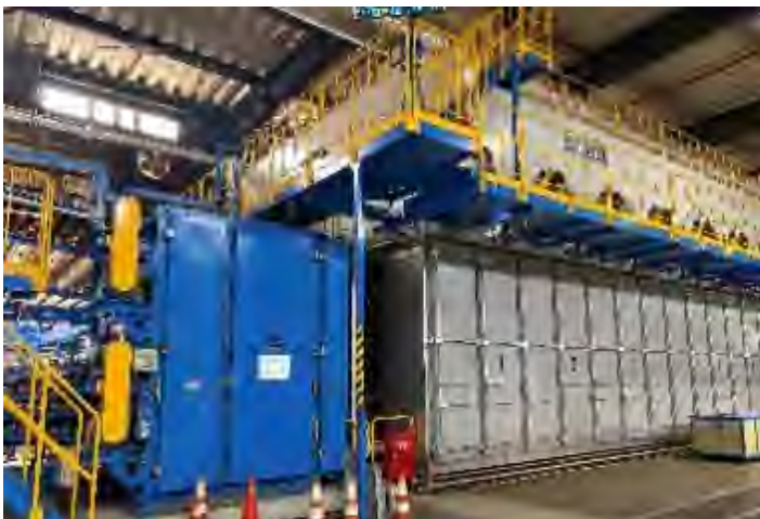
整備された単板の乾燥施設（新潟市）
