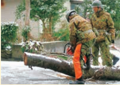
陸上自衛隊による道路啓開（倒木の切断）（柏崎市）
