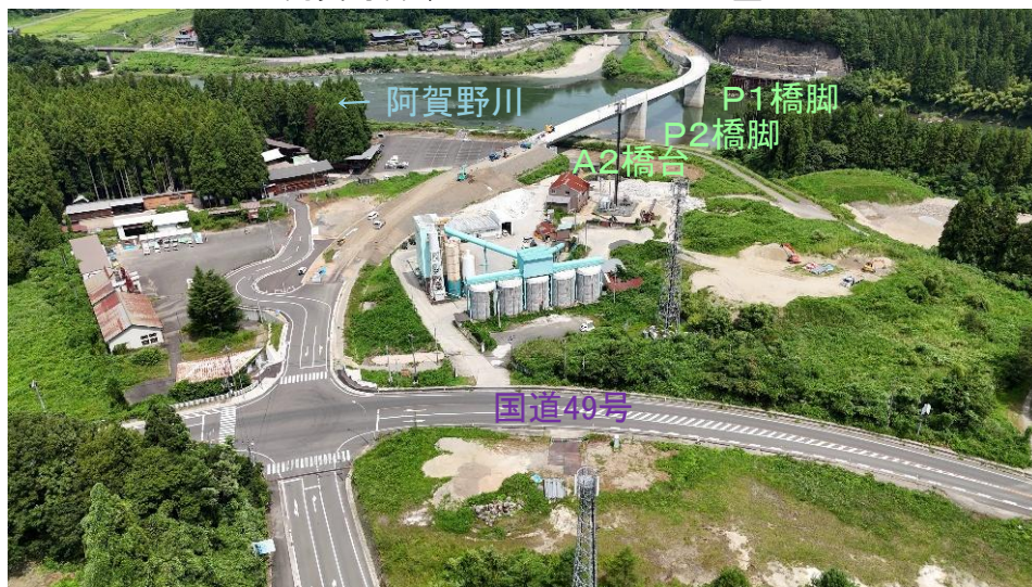
工事状況（令和8年8月） ※阿賀町吉津地内から川口地内を望む
