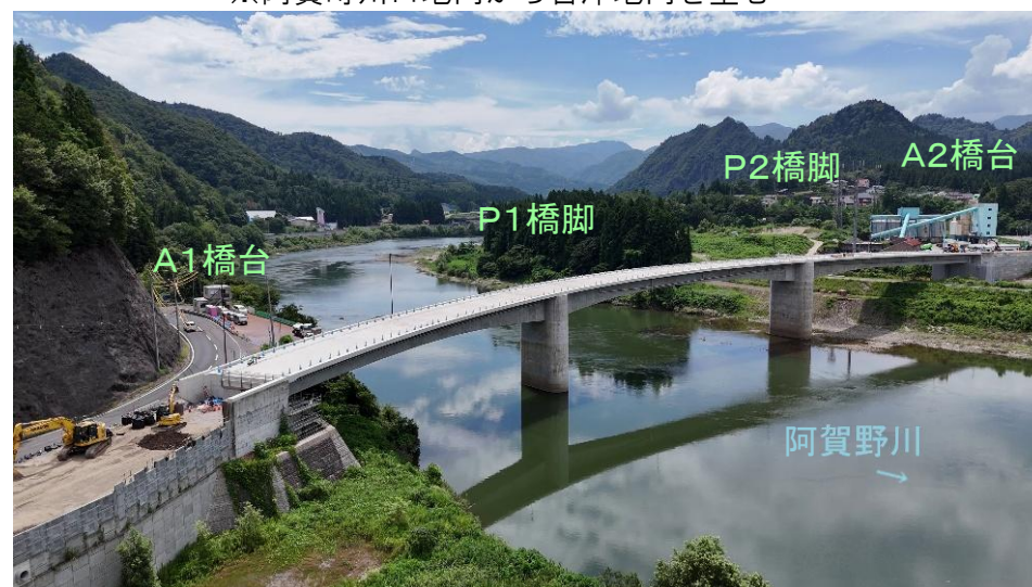
工事状況（令和8年8月） ※阿賀町川口地内から吉津地内を望む
