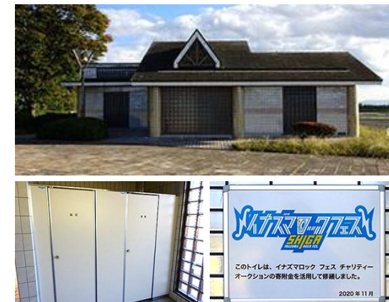
烏丸半島西トイレの改修（令和2年度）
