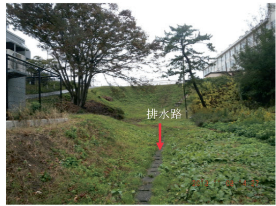
(b)排水路の水量が減少した通常の状態 (時刻 14:27 頃)
