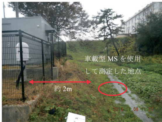
(a)排水路が溢れている状態 (時刻 11:27 頃)
