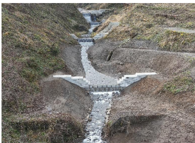
土砂流出の防止(妙高市)
