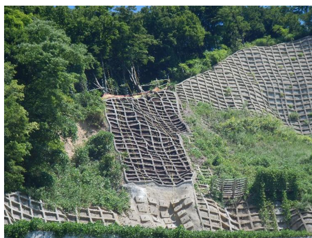
山腹崩壊の復旧(上越市)
