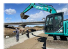
笠コンクリートブロック据付工
