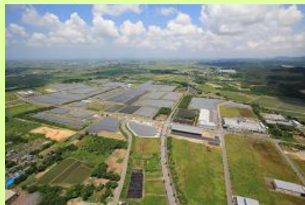
📷 平成27年7月1日に運転を開始した新潟東部太陽光発電所3号系列
