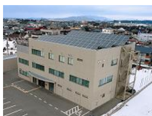
発電管理センター（村上市）
