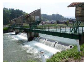
栃尾工業用水道 (長岡市)
