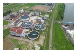
(写真) 上越利水事務所の施設全景
