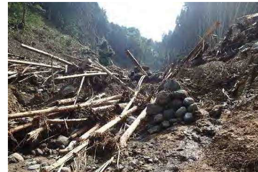
東峰村内の被害の様子
