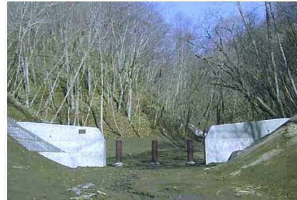
・治山ダム(スリットダム)の例
