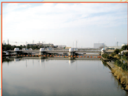
新発田川放水路 潮止堰
