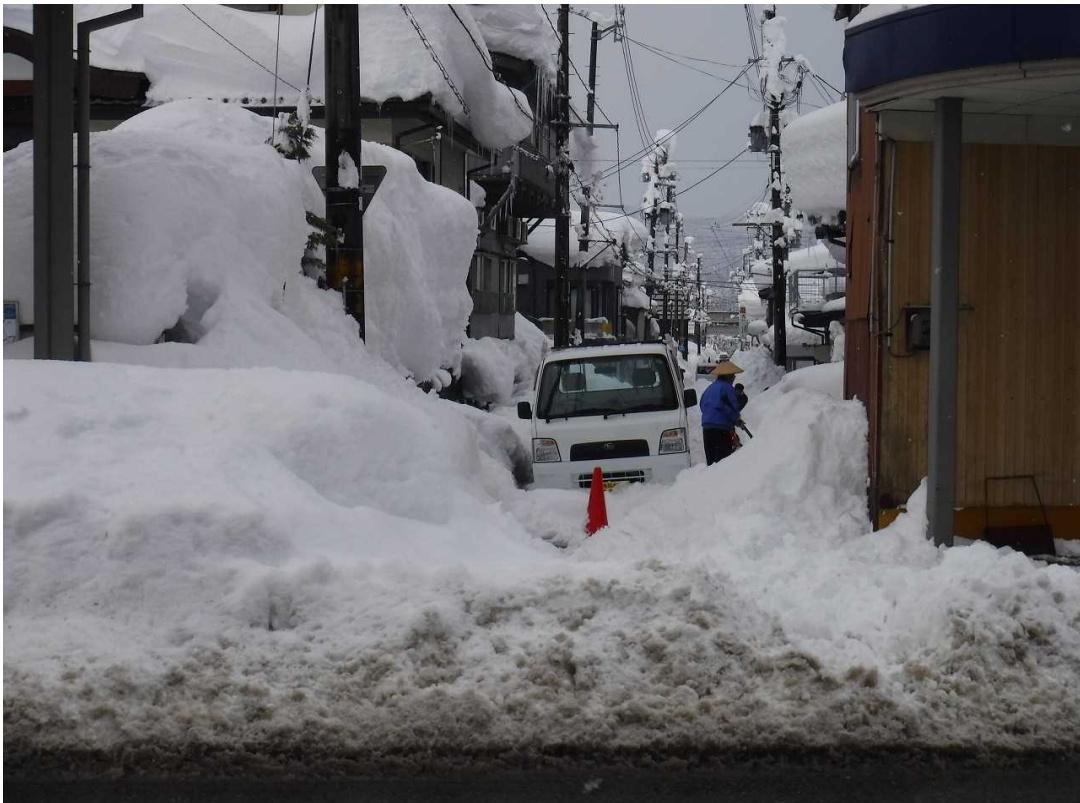
市道積雪状況（1/11十日町市）
