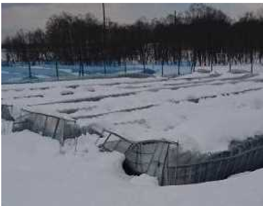
雪によるオータムポエム栽培ハウスの倒壊（1/13上越市大潟区）
