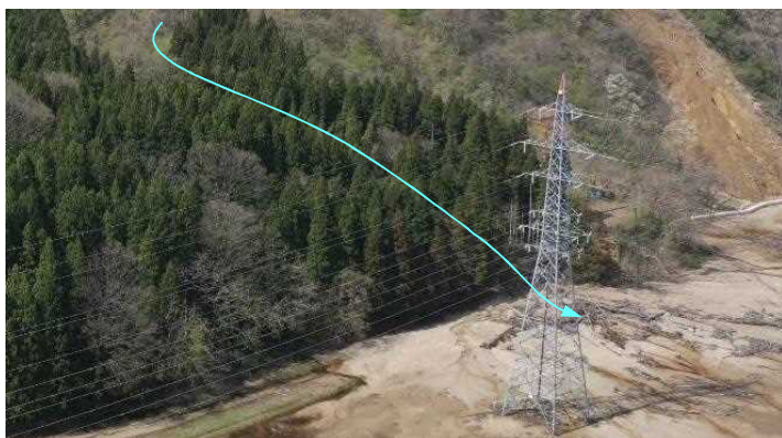
写真 1. 2. 5. 関川村田主沢の土砂及び流木流出 (SL-1 : II 型)
