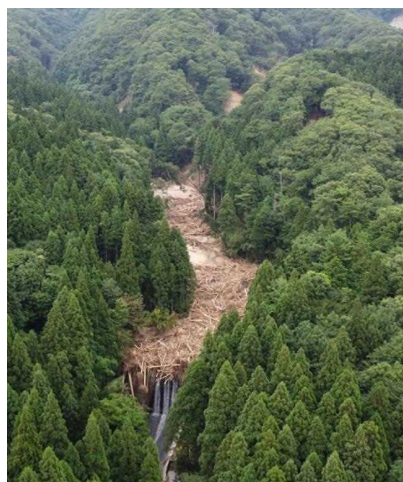
写真 2. 2. 1. 大量の流木を捕捉した不透過型ダム（MR-46 大沢川）
