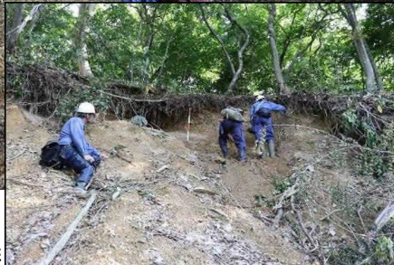
写真② 崩壊地の滑落崖
