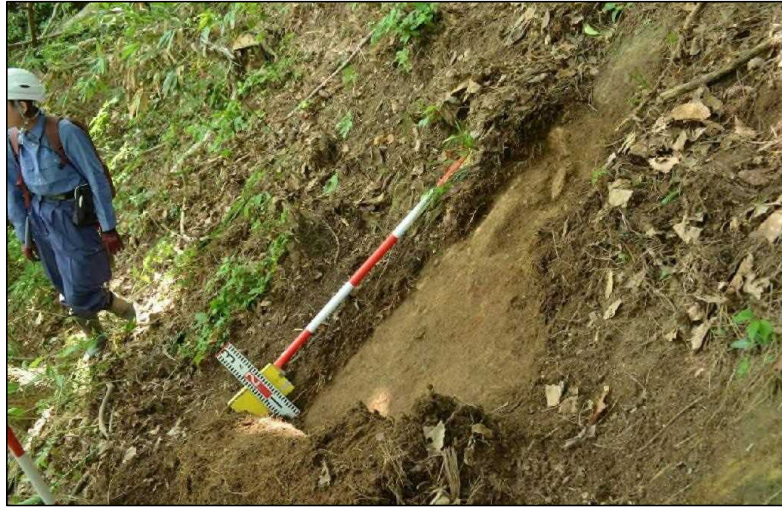
写真 2.5.8. S42 羽越災害山腹荒廃地の岩盤まで表土を剥いだ状況__MR-48 右岸側
