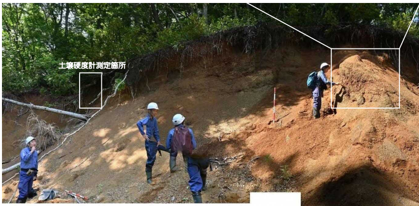
写真① 崩壊地頭部の状況
