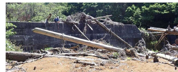
写真 2. 2. 2 (2). MR-39 赤坂川本川の一部透過型ダム上流堆砂状況
