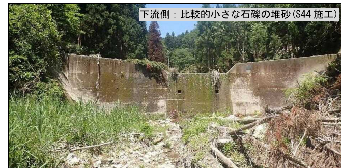
写真 2.5.3-1. 既設谷止工上下流の堆砂状況_MR-39（赤坂川）支流
