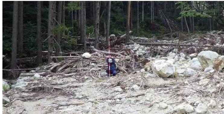
写真 1.3.2. 本数計測が不可能な事例 (SR-1, T-2 流木堆積地) ここでは平均堆積厚 2m, 空隙率=0.8 と推定
