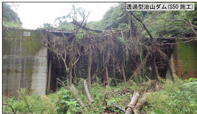
写真 2.5.2. 透過型治山ダムによる流木捕捉状況_MR-18（上江沢川）
