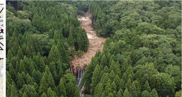
写真 1.2.1. 大沢川上流の既設砂防堰堤（MR-46：Ⅰ型） 大量の流木を捕捉
