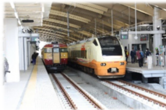
駅ホーム高架化完了
