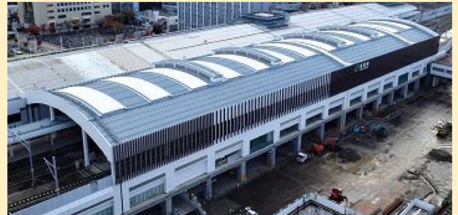
工事中の新潟駅（令和4年11月の状況）
