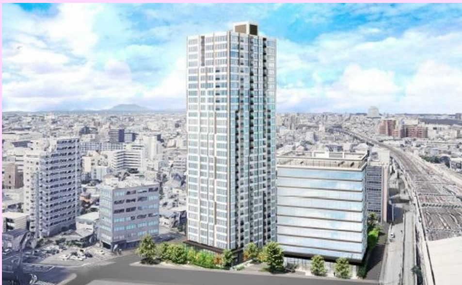
新潟駅南口西地区 オフィス棟・住宅棟・駐車場棟 (令和4年10月 建築工事着工)
