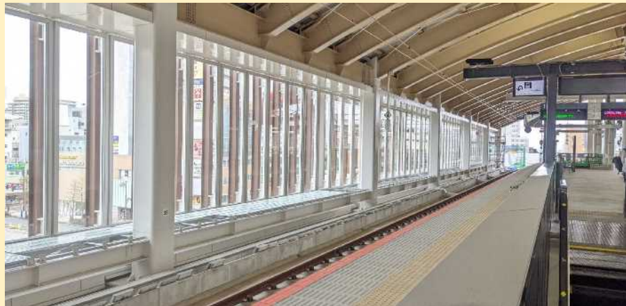
新潟駅在来線全線高架化（令和4年6月）
