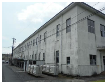
【現状施設の例(庁舎)】
