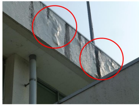
(ウ) B又はC (ひび割れが散見される) (エ) B又はC (外装塗材の剥がれや コンクリートの爆裂が散見される)
