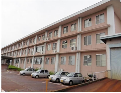
(ウ) B又はC (ひび割れが散見される) (エ) B又はC (外装塗材の剥がれや コンクリートの爆裂が散見される)
