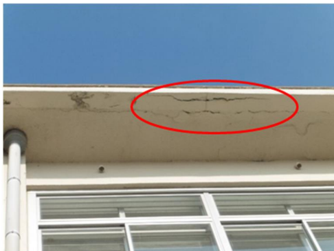
(ウ) B又はC (ひび割れが散見される) (エ) B又はC (外装塗材の剥がれや コンクリートの爆裂が散見される)
