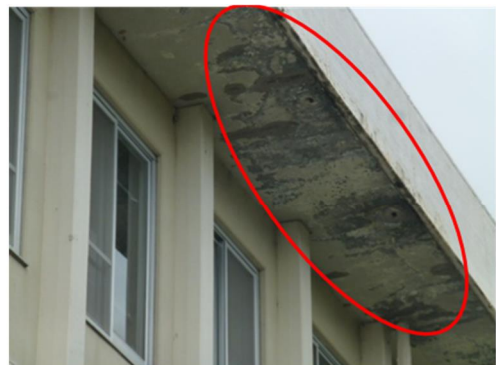
(ウ) B又はC (ひび割れが散見される) (エ) B又はC (外装塗材の剥がれや コンクリートの爆裂が散見される)
