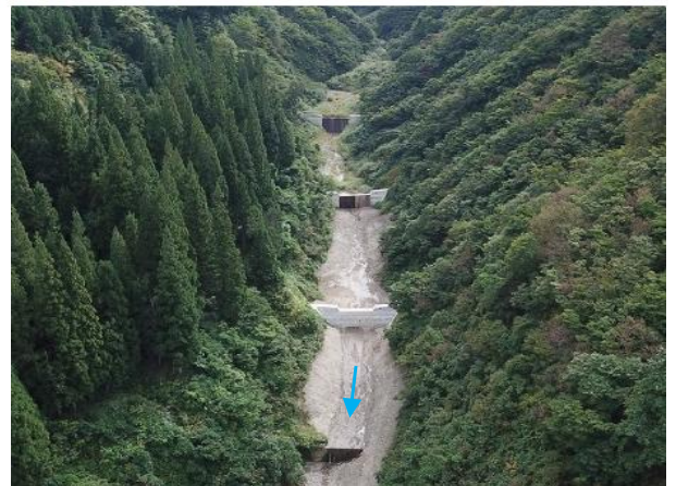
流域保全総合治山事業・谷止工(十日町市八箇南沢)
