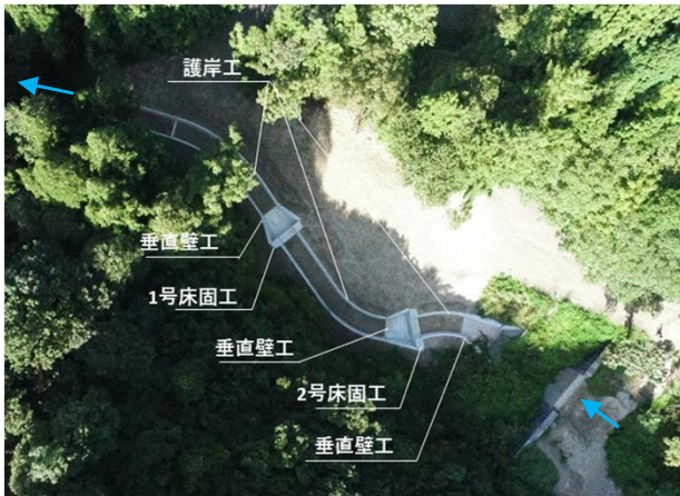
緊急予防治山事業・流路工(南魚沼市大月)
