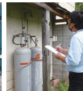
ガスメーターの立入検査
