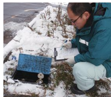
水道メーターの立入検査
