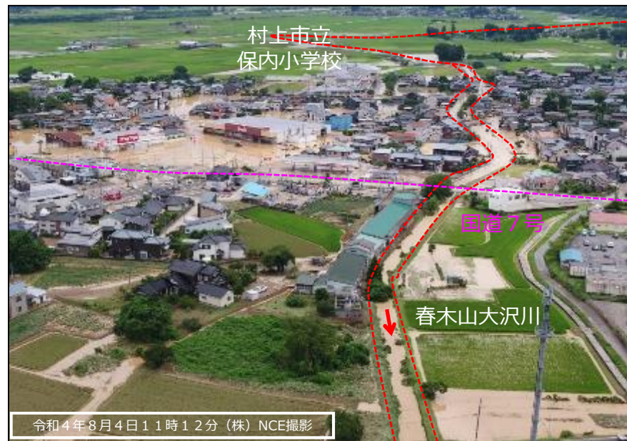
春木山大沢川 国道7号横断部
