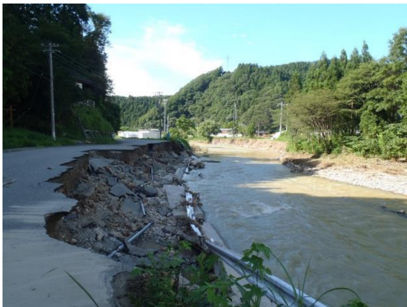
二級河川勝木川（村上市立島）
