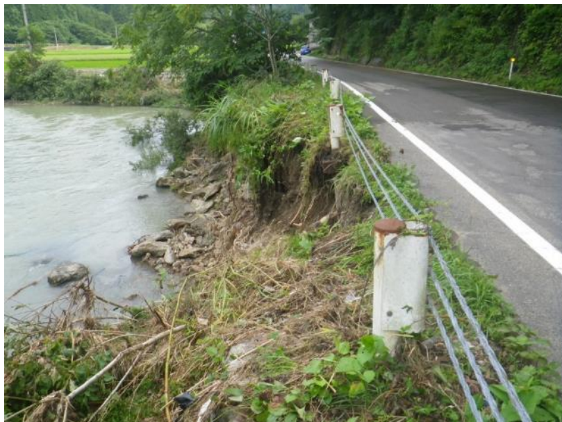
一般県道山熊田停車場線（村上市荒川口）
