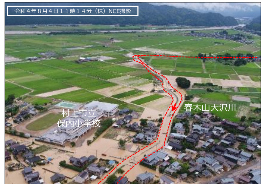
村上市立保内小学校付近
