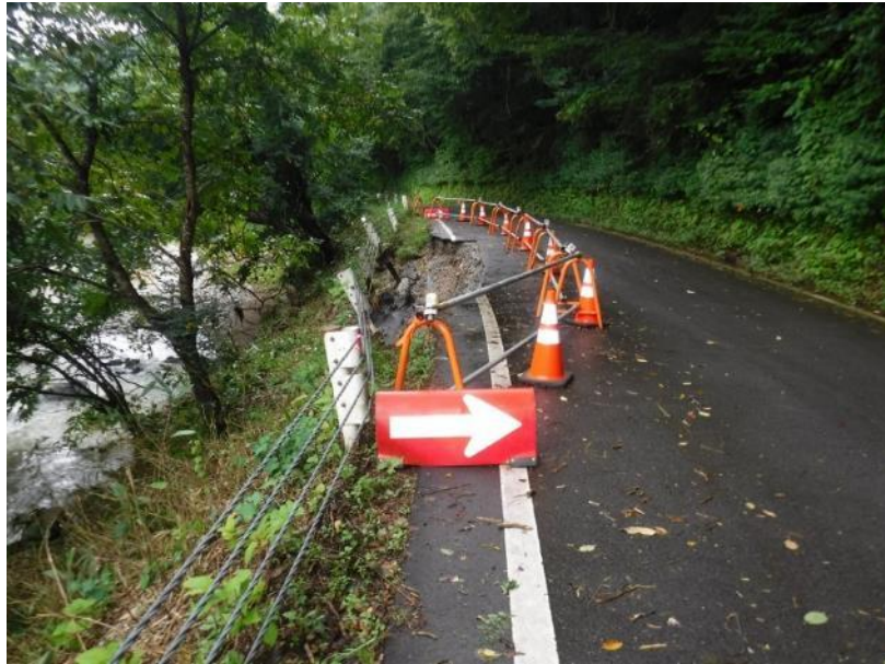
主要地方道山北関川線（村上市小俣）
