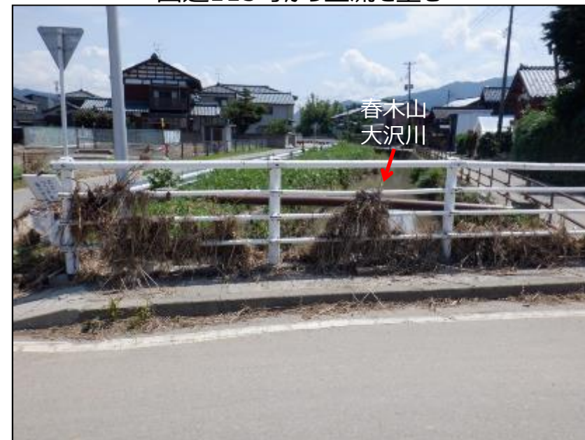
保内小学校付近の市道橋から上流を望む
