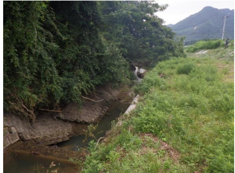
一級河川太田沢川（関川村若山）
