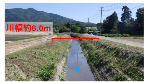
市道荒島1号線上流 河道整備前 令和5年5月
