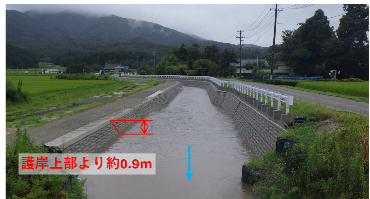
写真② 出水時 令和7年8月15日10時頃
