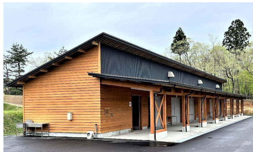
県産材を外構に使用した施設（上越市）
