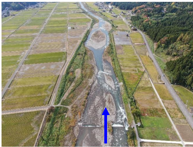
能生川の河床掘削（糸魚川市大字大王地内）
