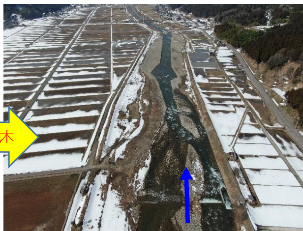
河道掘削、河道内伐木(洪水氾濫対策)
