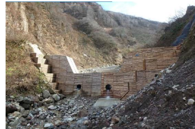
治山ダムの整備(治山対策)
