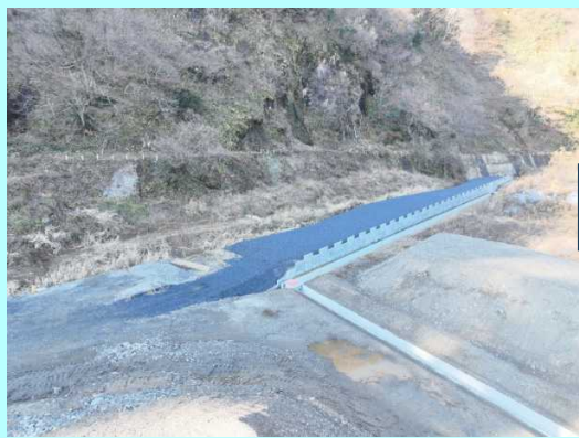
工事着手前写真
