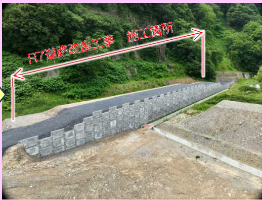
工事完成写真
