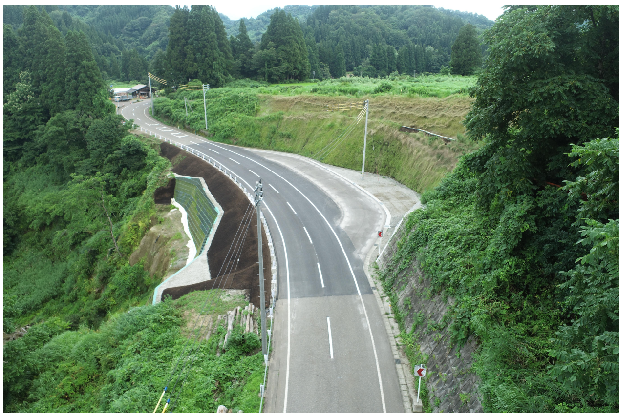
写真③ 災害復旧工事が完了（令和8年7月27日撮影）
