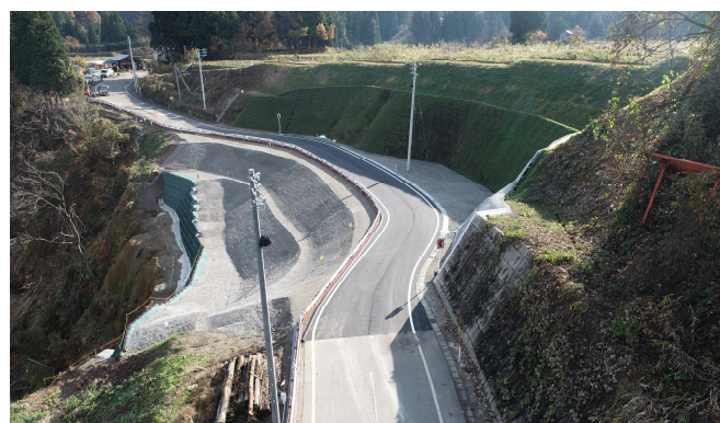
写真② 仮道完成状況（令和7年11月27日撮影）
