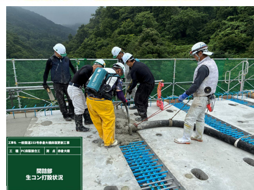
床版間詰め部のコンクリート打設作業
