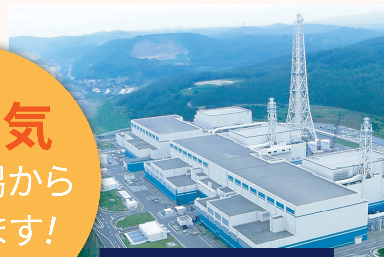
柏崎刈羽原子力発電所
