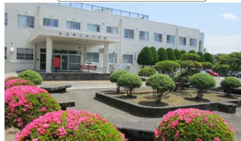
津川病院：R8現在 築54年目
