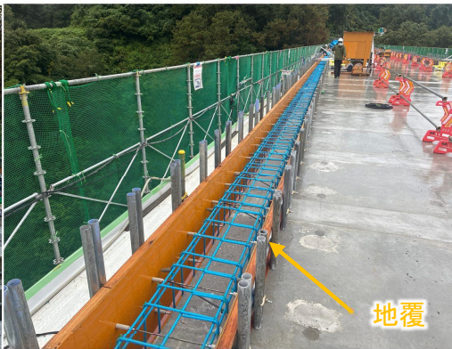
地覆の鉄筋組立・型枠設置完了
