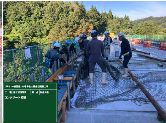
地覆のコンクリート打設状況
