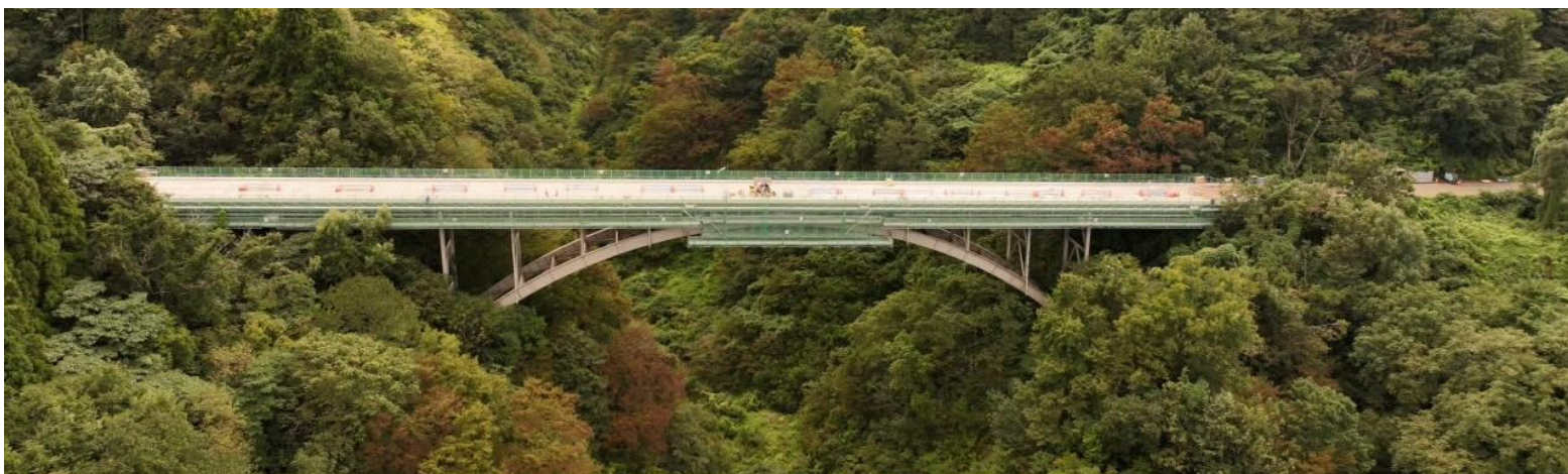
9月25日時点 ドローンによる全景写真
